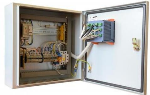
Шкаф управления серии EnIn-Π01-XX с сенсорным экраном и с возможностью Web – визуализации:
